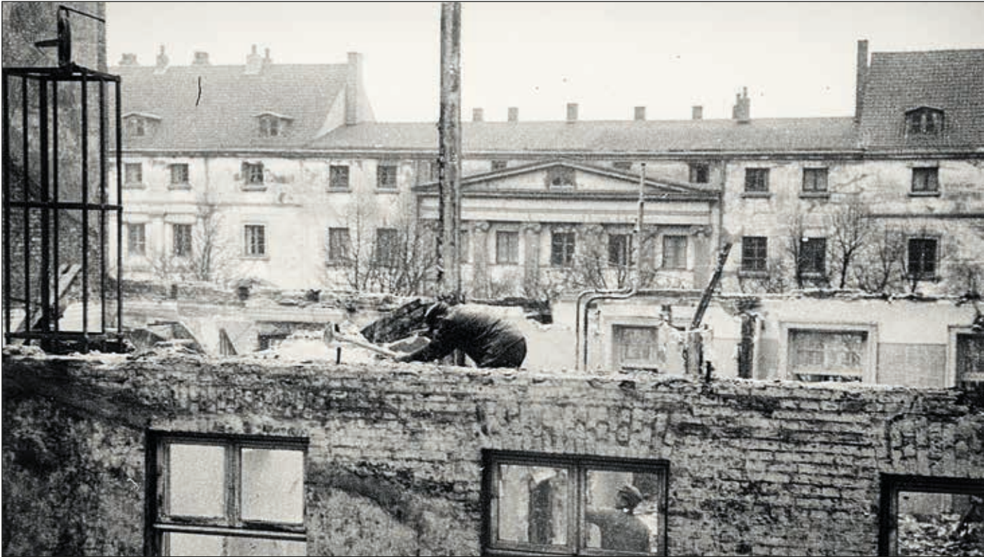
Die alten Vorderhäuser werden abgerissen. Gegenüber sieht man das alte Stadtpalais.
