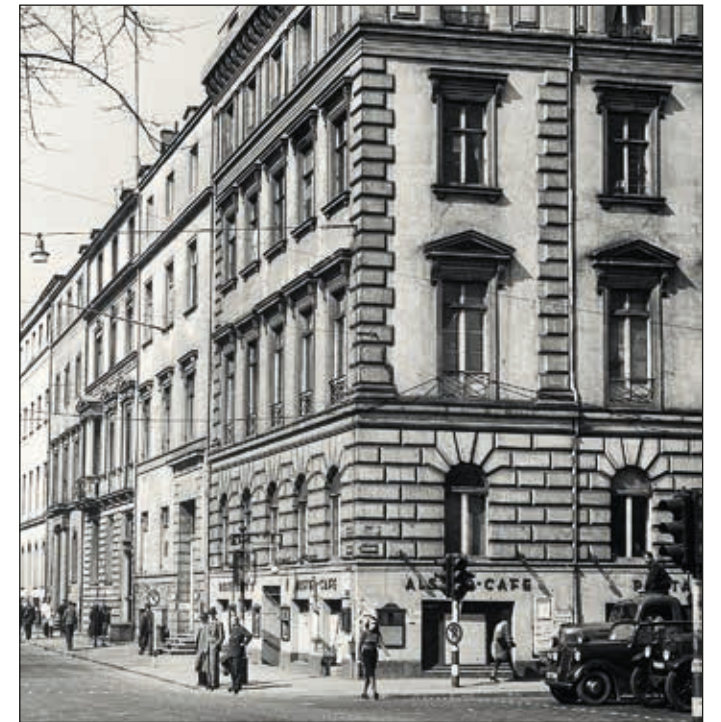
Die dem Hotel gegenüber- liegende Nordseite der Esplanade um 1948
