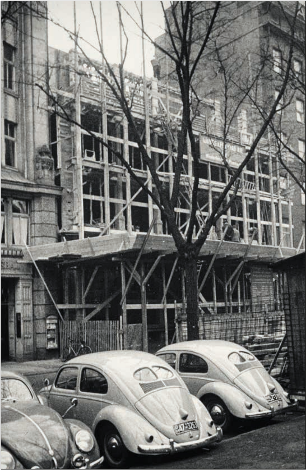
Der Neubau (1954) im Gerüst Foto: Ruth Kleinhuis
